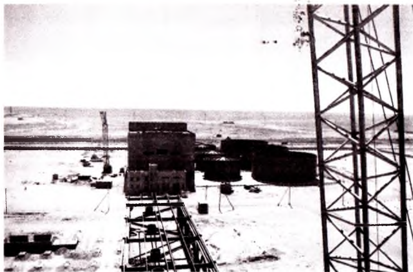
Кўнғирот сода заводи қурилиши
